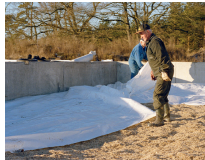
Vik in plastfolien från siloväggarna.
