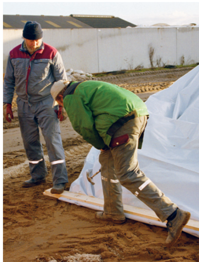
Vid inläggning i Hård-Pack sköter Nordic Sugar eller Nordic Sugars entreprenör hela jobbet med inläggningen. HP-Massa packas in i plastfolie eller plasttub med specialmaskiner. När inläggningen är klar skall du täcka avslutningsändan med sand eller grus.
