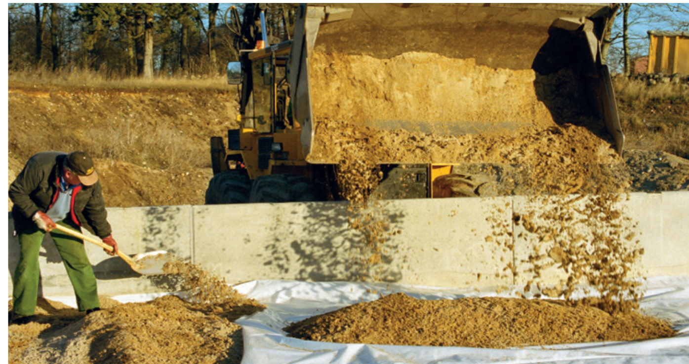
Täck plasten med ett 5 cm tjockt sandlager.
