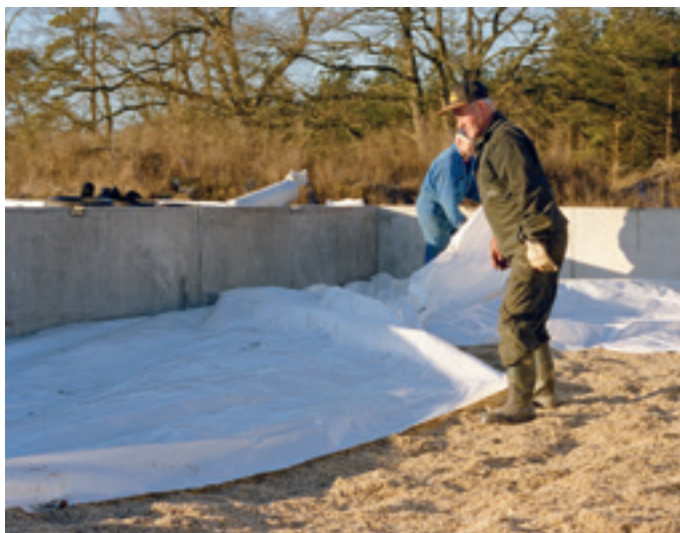
Træk plastfolien ind fra siloens sider og saml den på midten.
