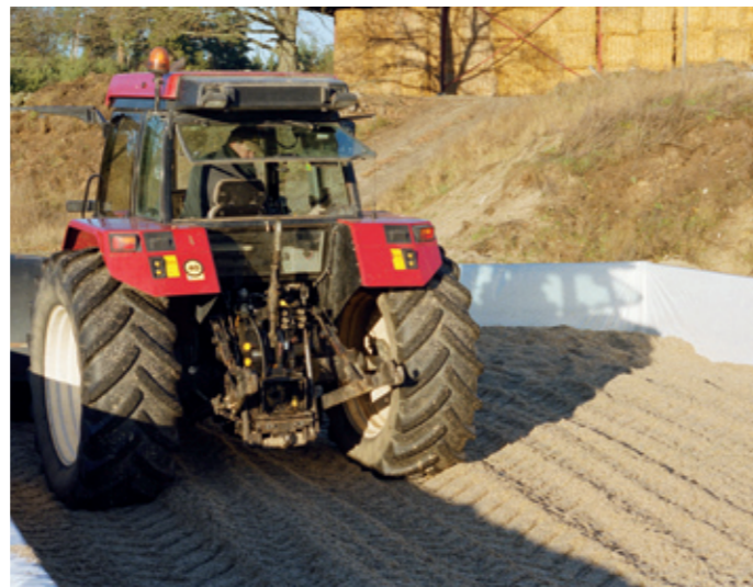
Efter avslutad inläggning packa omsorgsfullt med fyrhjulsdreven traktor.
